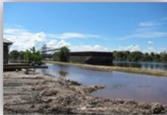
Existing Telang baru jetty
