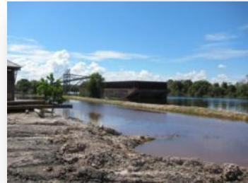
Telang baru jetty
